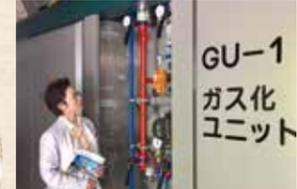
↑「飛騨高山しぶきの湯 バイオマス発電所」では、未利用木材を加工した木質ペレットを発電燃料として利用する「小型高効率木質ペレットガス化熱電供給システム」を採用し、電気と熱を活用する再生可能エネルギー発電事業を推進しています。
